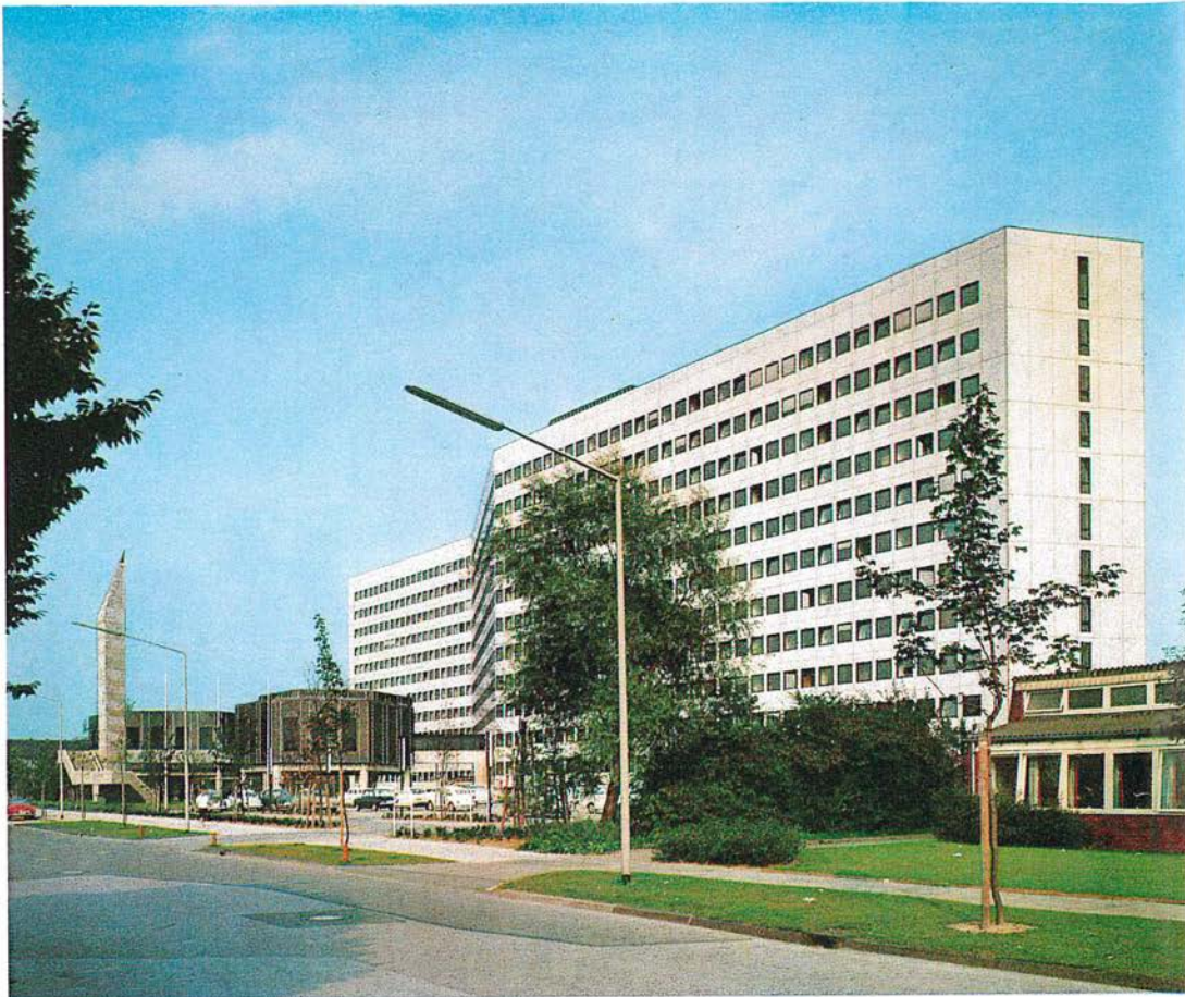
Blick von der Andreas-Hofer-Straße auf die Gesamtanlage
