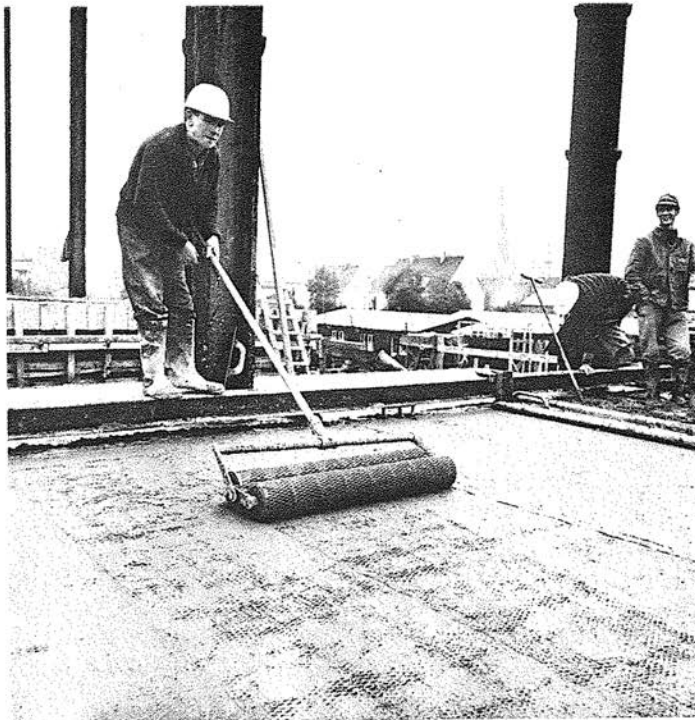
Abb. 13 Oberflächenbehandlung des Frischbetons mit einer Lochwalze
