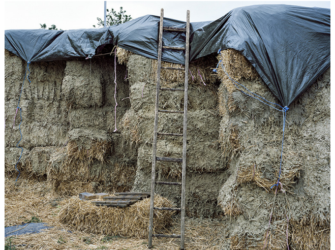
Le mur de défense des jardins ouvriers des Vertus (échelle), Aubervilliers, 29 avril 2021 2021
