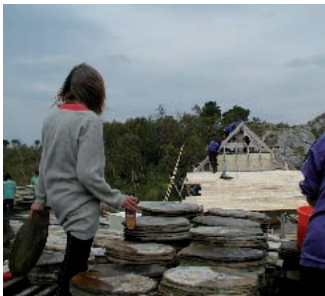
Construcción de una casa tailandesa, agosto de 2006 / Building Thai house, August 2006
